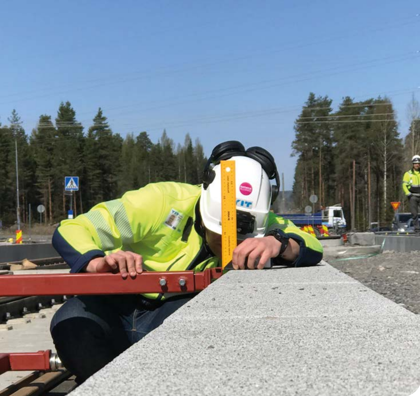
Ratikkapysäkkien esteettömyyttä varmistetaan nyt millimetrien tarkkuudella. (kuva: Raitiotieallianssi)
