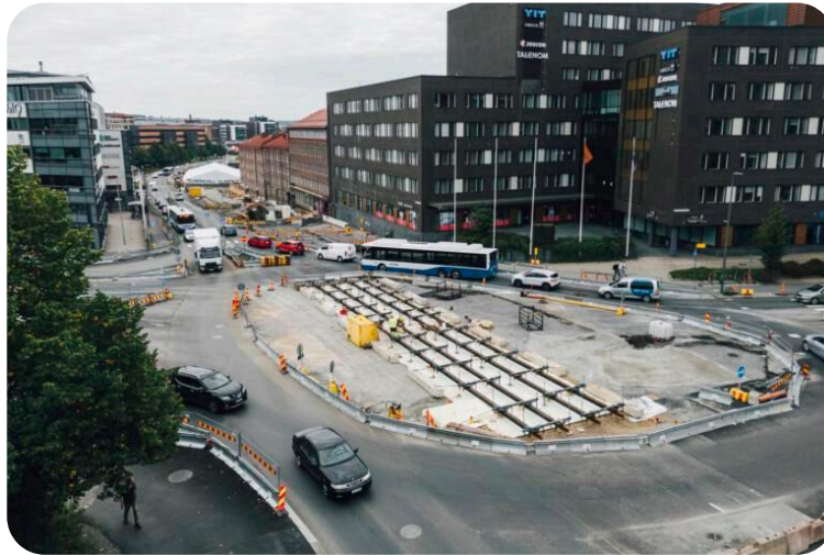
Kiskojen asennusta Hatunpään valtatiellä.
